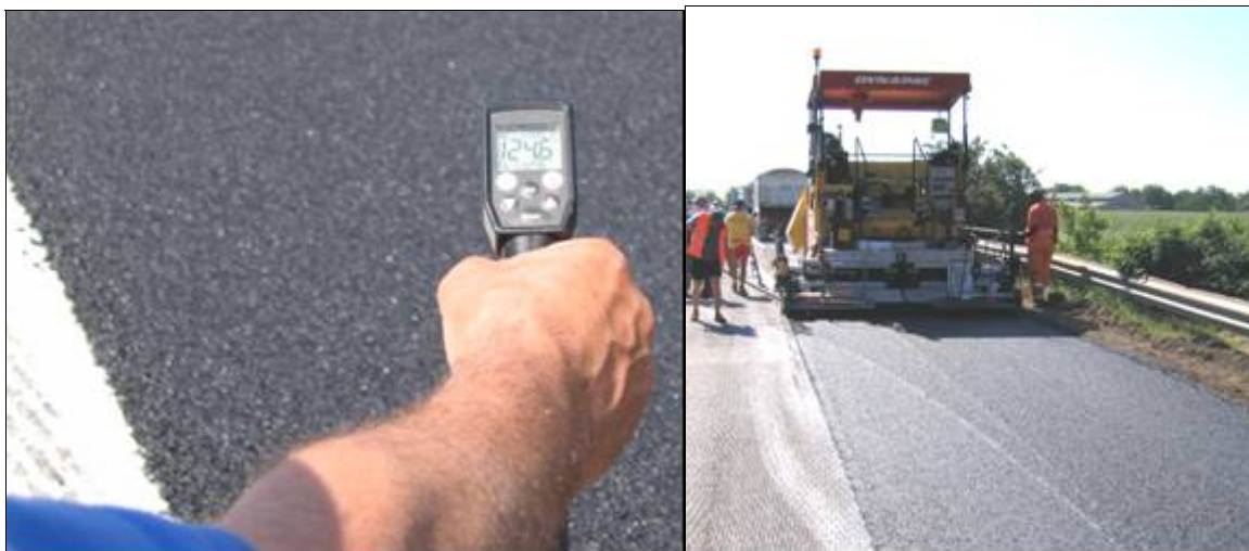
Figura 2: stesa del conglomerato SMA “Antiskid” tiepido e verifica delle temperature
